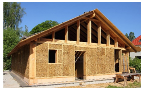
Brique en encadrement de fenêtres, laine de mouton, chanvre et bottes de paille.
