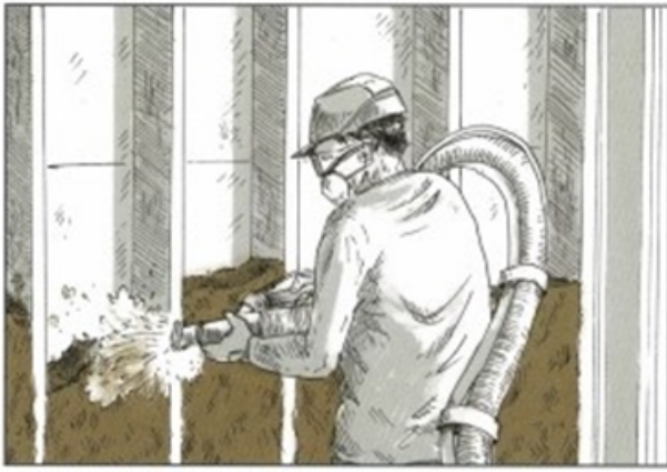
LE BÉTON DE CHANVRE EST PROJETÉ DEPUIS L'EXTÉRIEUR, EN VÉRIFIANT L'ÉPAISSEUR À L'AIDE D'UN NIVEAU LASER.
